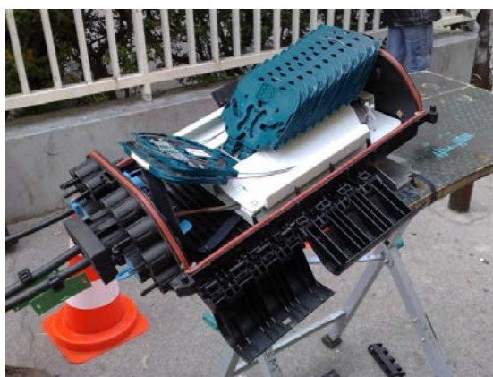
Figure 4 : Boîtier de protection d'épissure contenant les prévisions de cassettes pour de futurs partages
